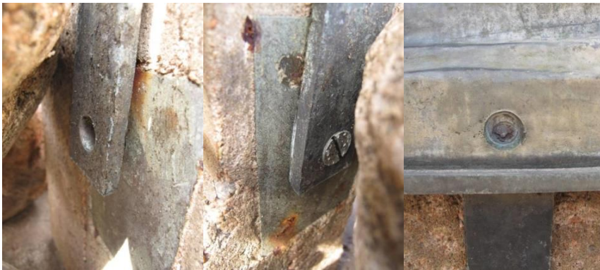
Bronsskruv saknas
